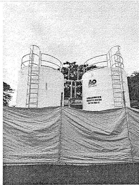
Cerramiento área intervenida
