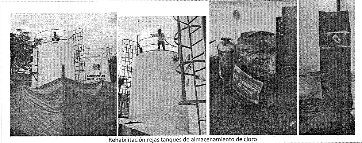
Rehabilitación rejas tanques de almacenamiento de cloro
