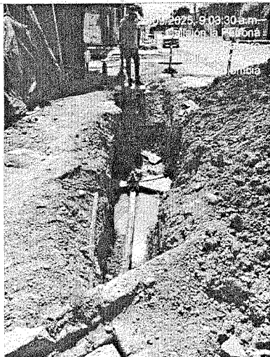
Instalación de tubería
