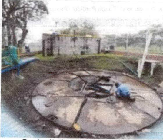
Terminación demolición Tanque metálico
