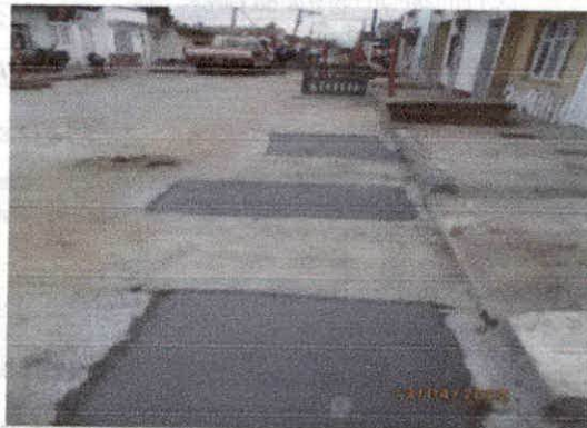
Reconstrucción de pavimento calle 41 entre cras 36-37
