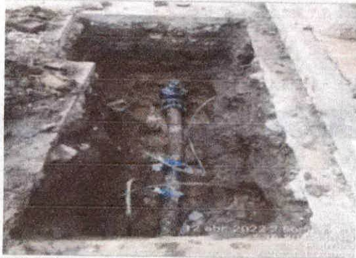
Instalación de domiciliarias Calle 41 entre cras 36 -37
