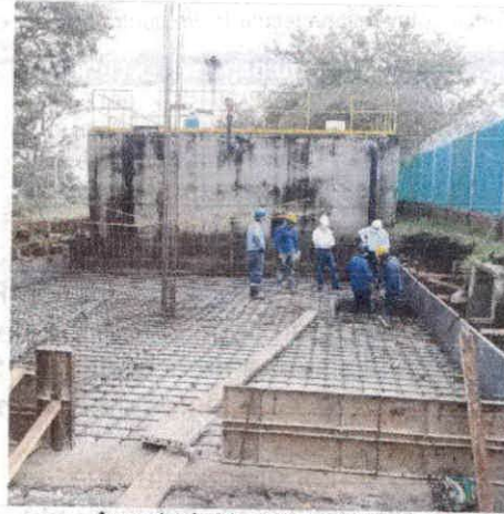
Armado de hierro losa de fondo
