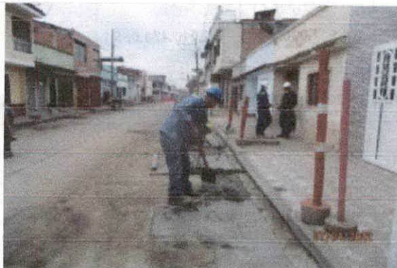
Colocación de pavimento en concreto Cra 33 entre 34-35
