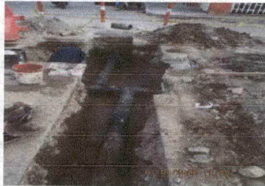
Instalación de tubería PAED DN 160, Cra 33 entre calle 34-35
