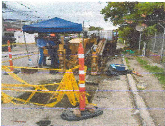
Ilustración 11 Lanzamiento tubería
