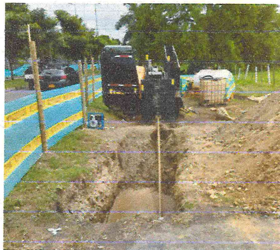
Ilustración 12 Lanzamiento tubería
