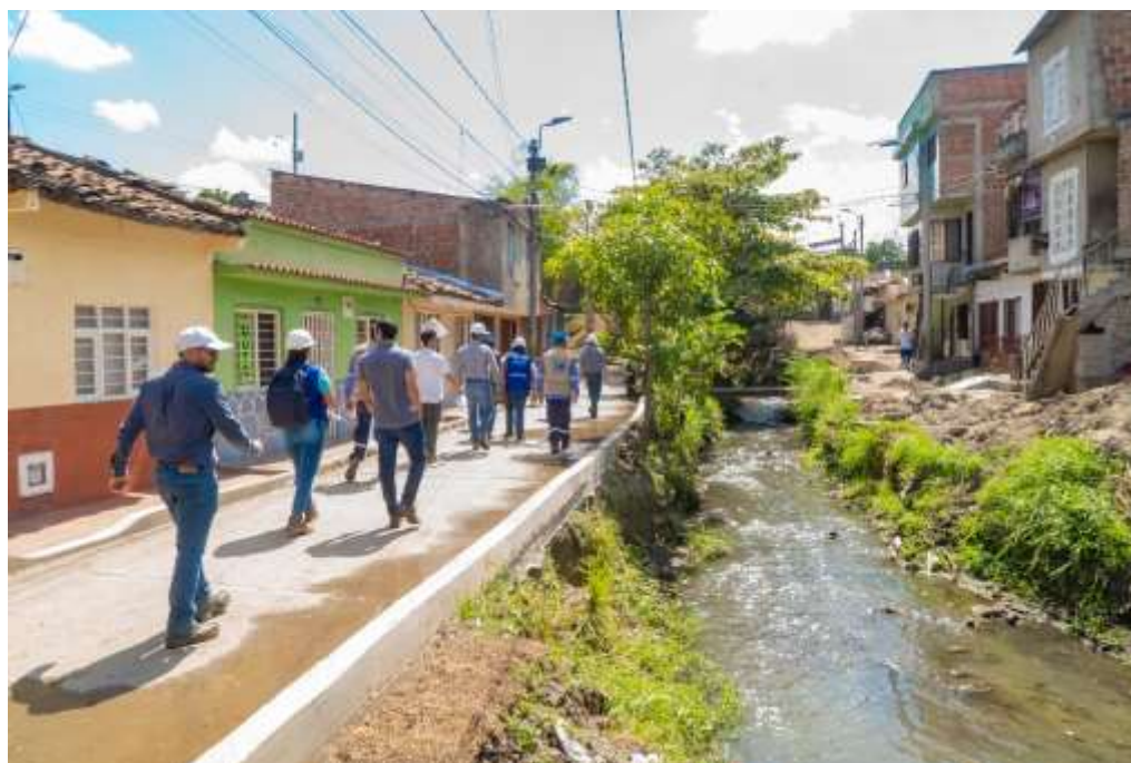
Imagen 6. Visita a Construcción del colector Río Palmira parte alta margen derecho (3)
