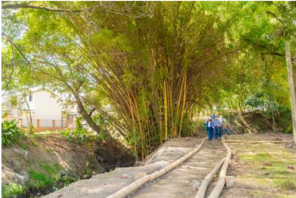
Imagen 5. Visita a Construcción del colector Río Palmira parte alta margen derecho (2)
