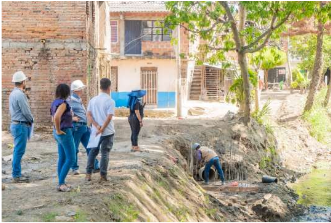
Imagen 4. Visita a Construcción del colector Río Palmira parte alta margen derecho (1)
