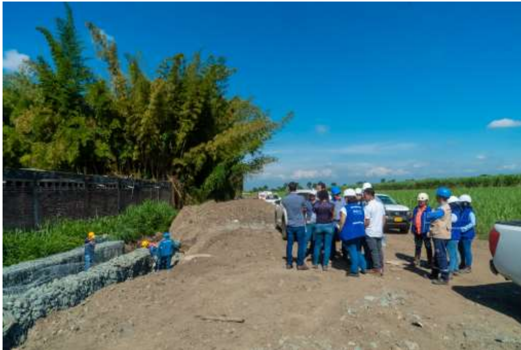
Imagen 1. Visita a Construcción del colector de alcantarillado primera etapa San Pablo-Roas (1)
