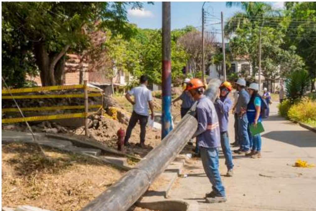
Imagen 8. Visita a Construcción del colector Río Palmira parte alta margen izquierdo (2)
