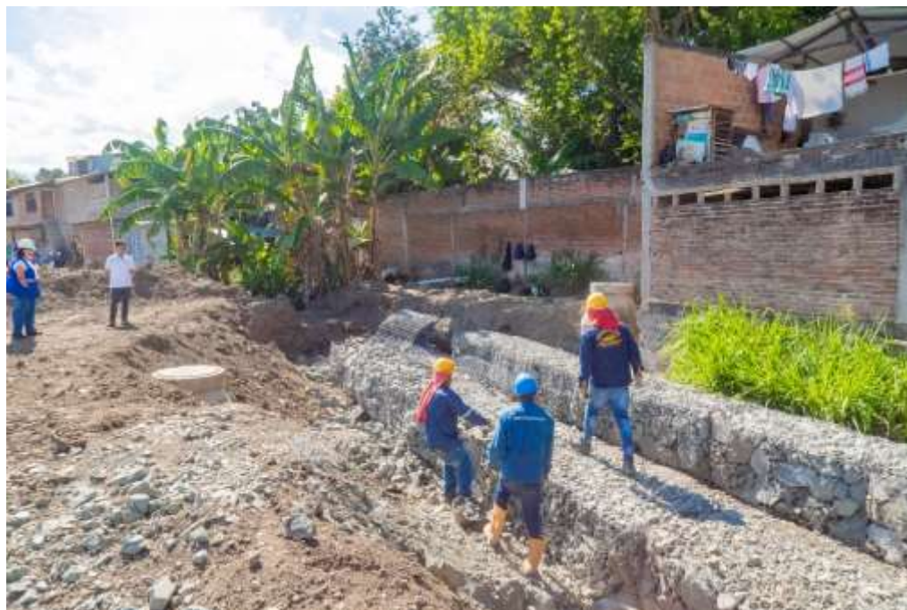
Imagen 3. Visita a Construcción del colector de alcantarillado primera etapa San Pablo-Roas (3)
