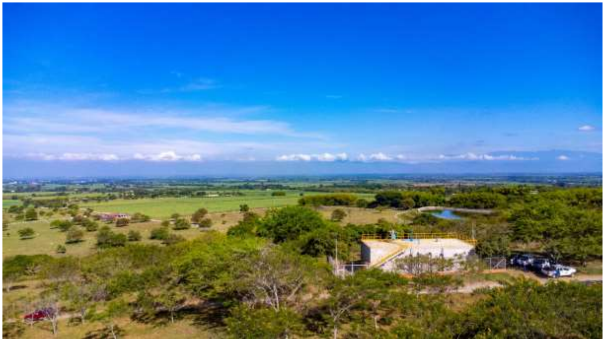
Imagen 10. Visita a Tanque de Almacenamiento de 600m 3 en el corregimiento de Tienda Nueva (1)
