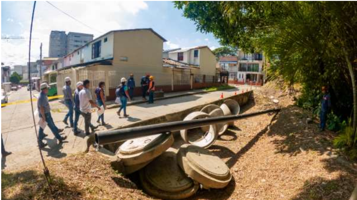
Imagen 7. Visita a Construcción del colector Río Palmira parte alta margen izquierdo (1)
