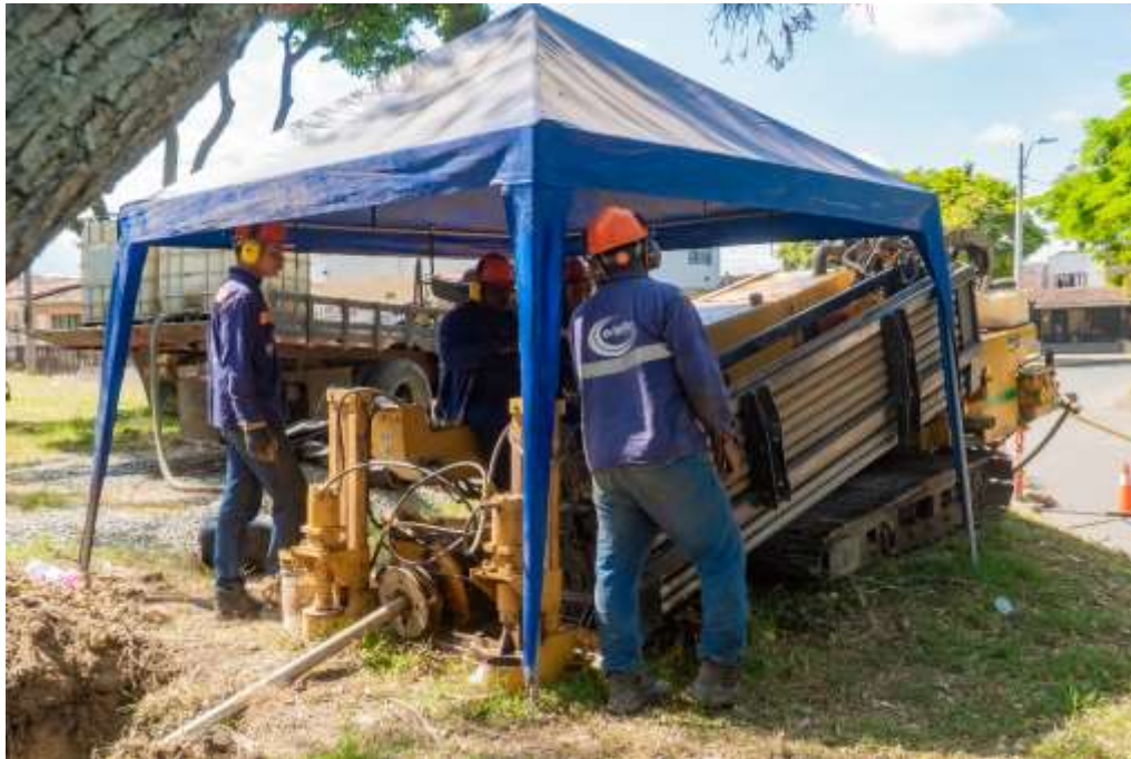
Imagen 9. Visita a Construcción del colector Río Palmira parte alta margen izquierdo (3)
