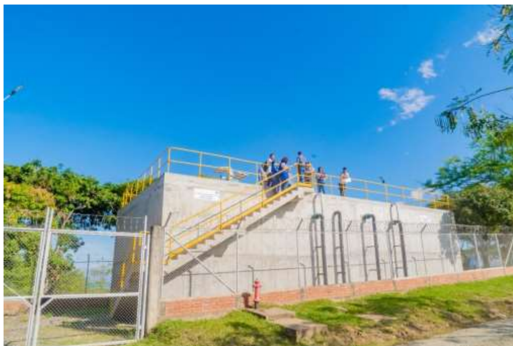
Imagen 11. Visita a Tanque de Almacenamiento de 600m 3 en el corregimiento de Tienda Nueva (2)
