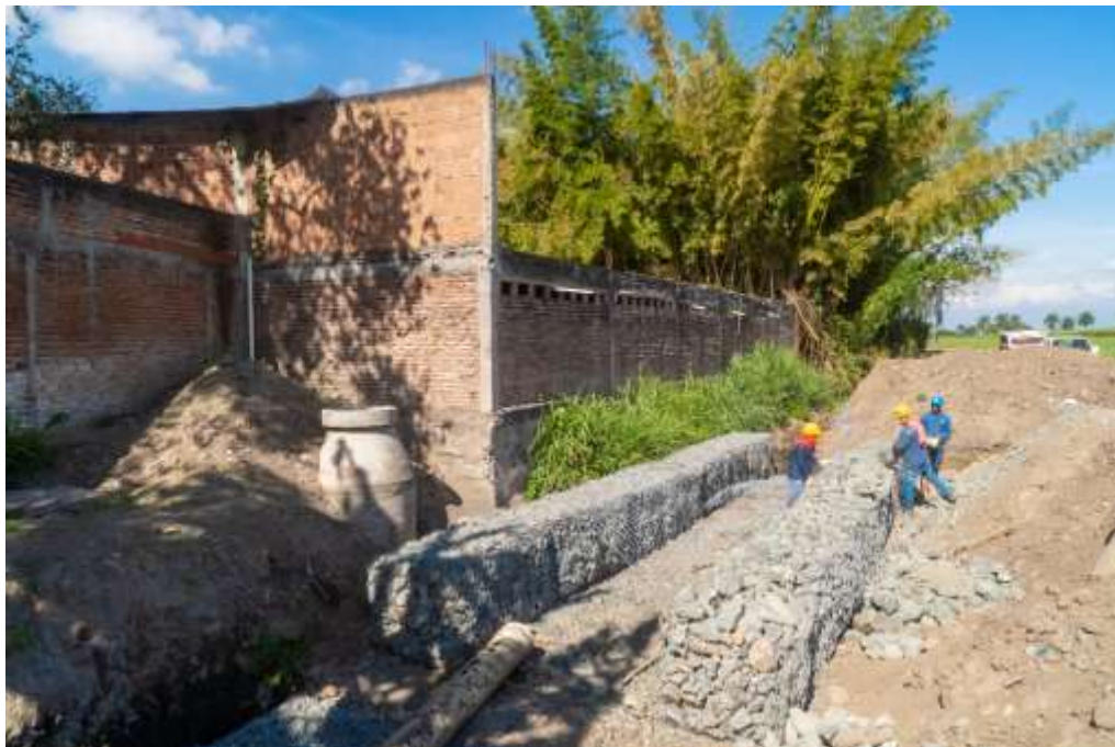
Imagen 2. Visita a Construcción del colector de alcantarillado primera etapa San Pablo-Roas (2)
