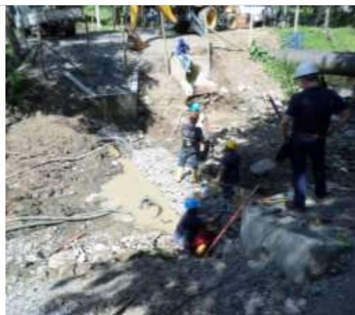
Ilustración 2 Construcción colchón tipo reno
